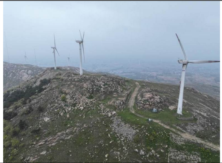
项目拟拆除风机周边现状照片（2）
