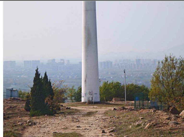
本次拟拆除 1#风机点位
