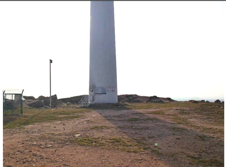
本次拟拆除 4#风机点位
