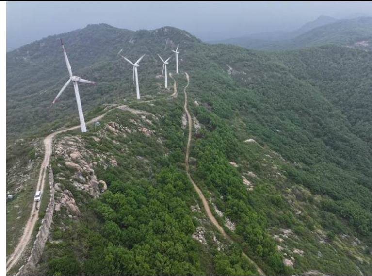
项目拟拆除风机周边现状照片（1）
