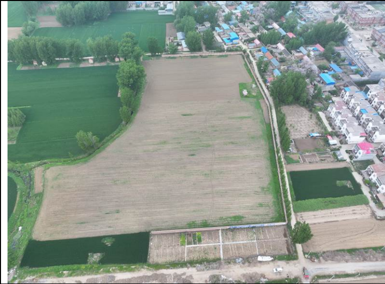
项目拆旧储存区周边现状照片
