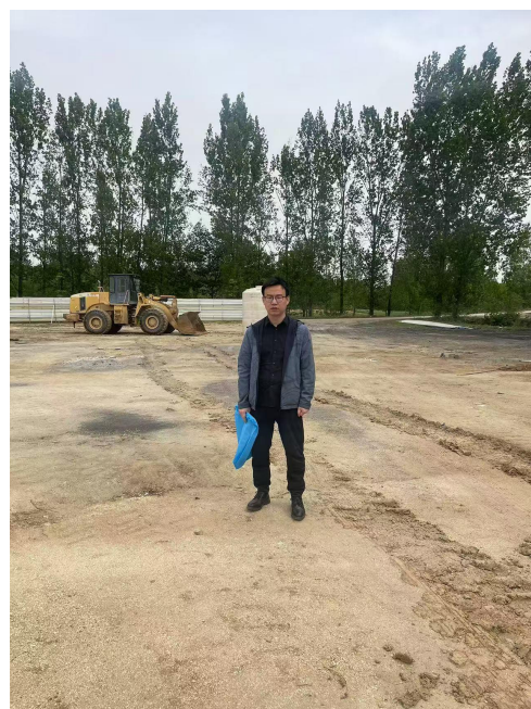
厂区北部及工程师现场勘查照片
