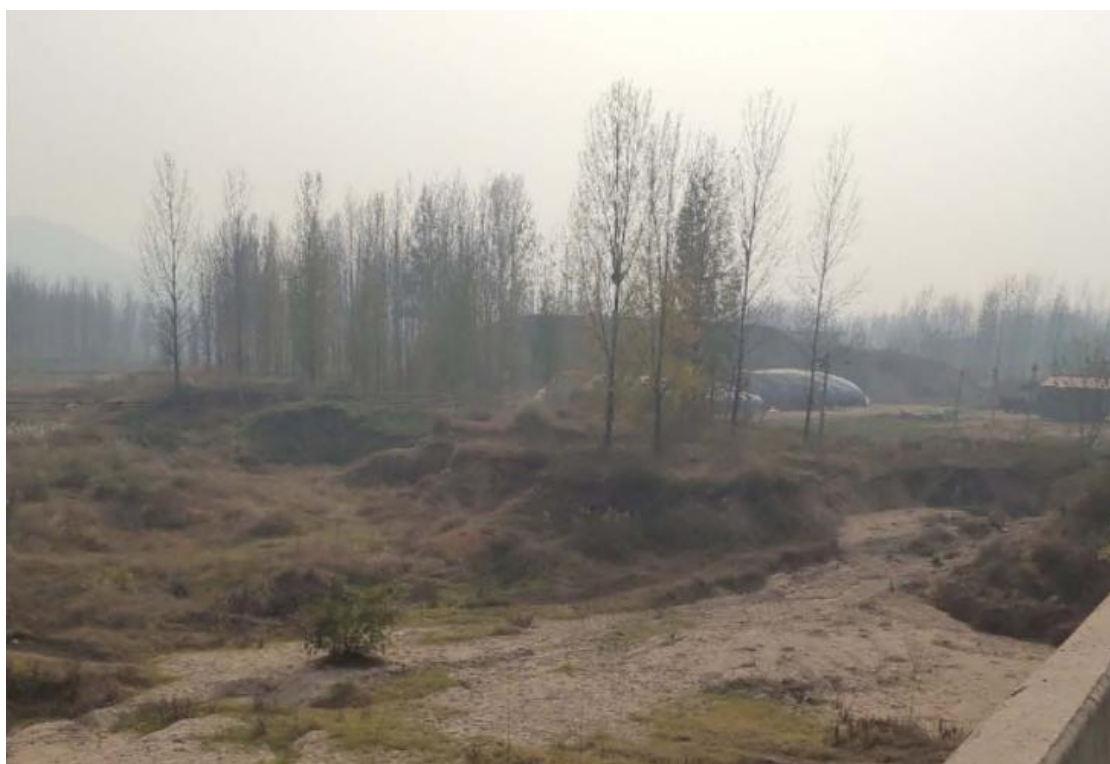
桩号 6+300 左岸岸坡
