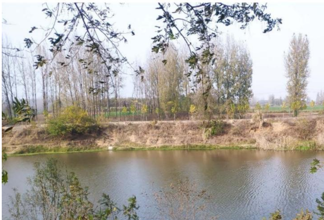
桩号 4+600 左岸岸坡
