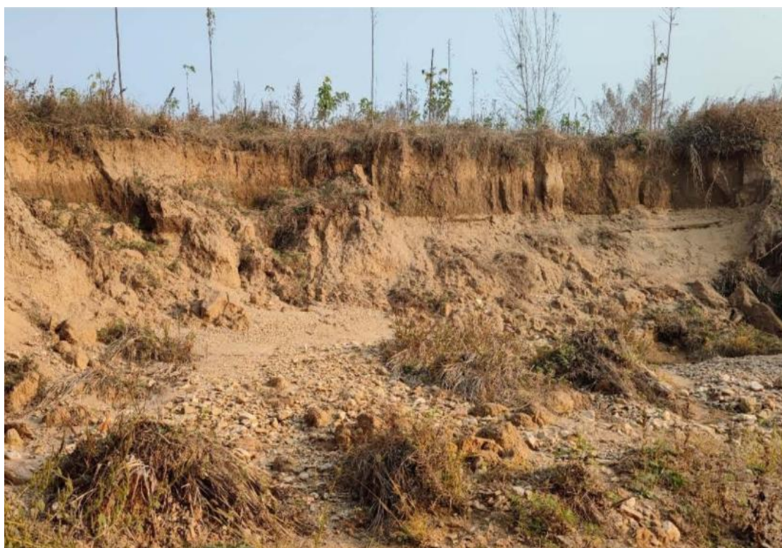
桩号 3+500 右岸岸坡
