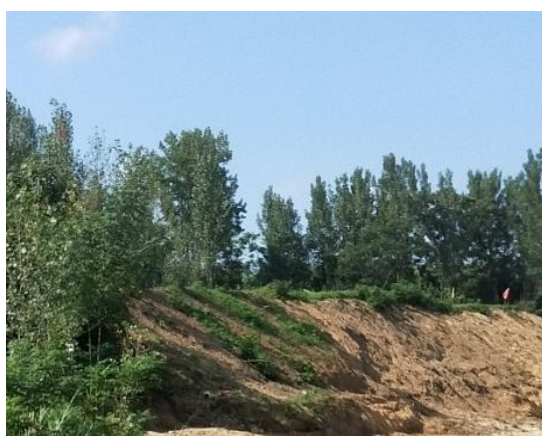
桩号 6+600 现状河岸
