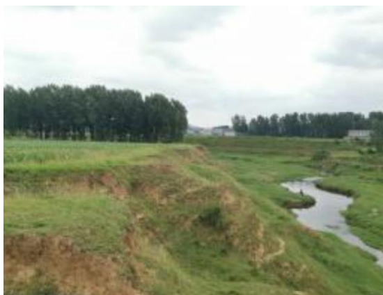
桩号 9+550 现状河岸
