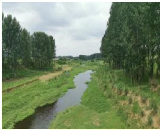
桩号 9+100 现状河岸
