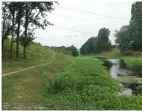
桩号 5+150 现状河岸
