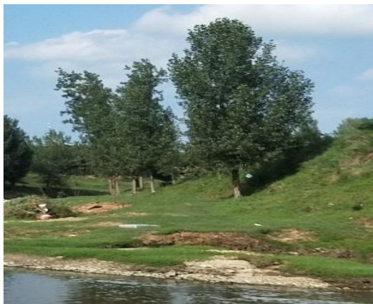
桩号 6+500 现状河岸
