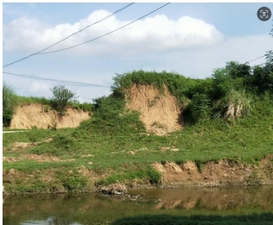
桩号 6+600 现状河岸
