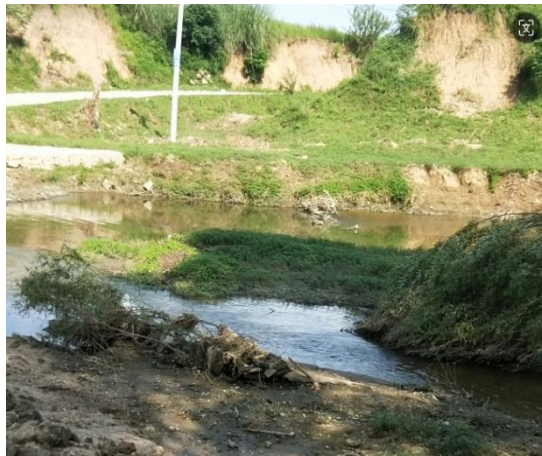
桩号 6+400 现状河岸
