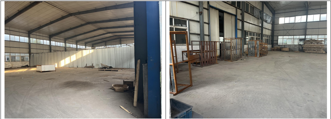
厂房内部照片
