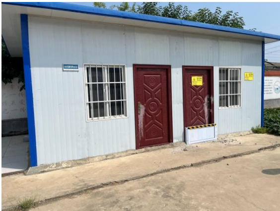
现有医疗废物暂存间
